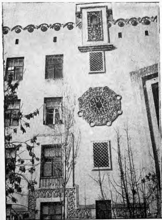
Рис. 23. Решетчатая розетка на фасаде здания Средазуголь в Ташкенте (архитектор А. А. Сидоров).
