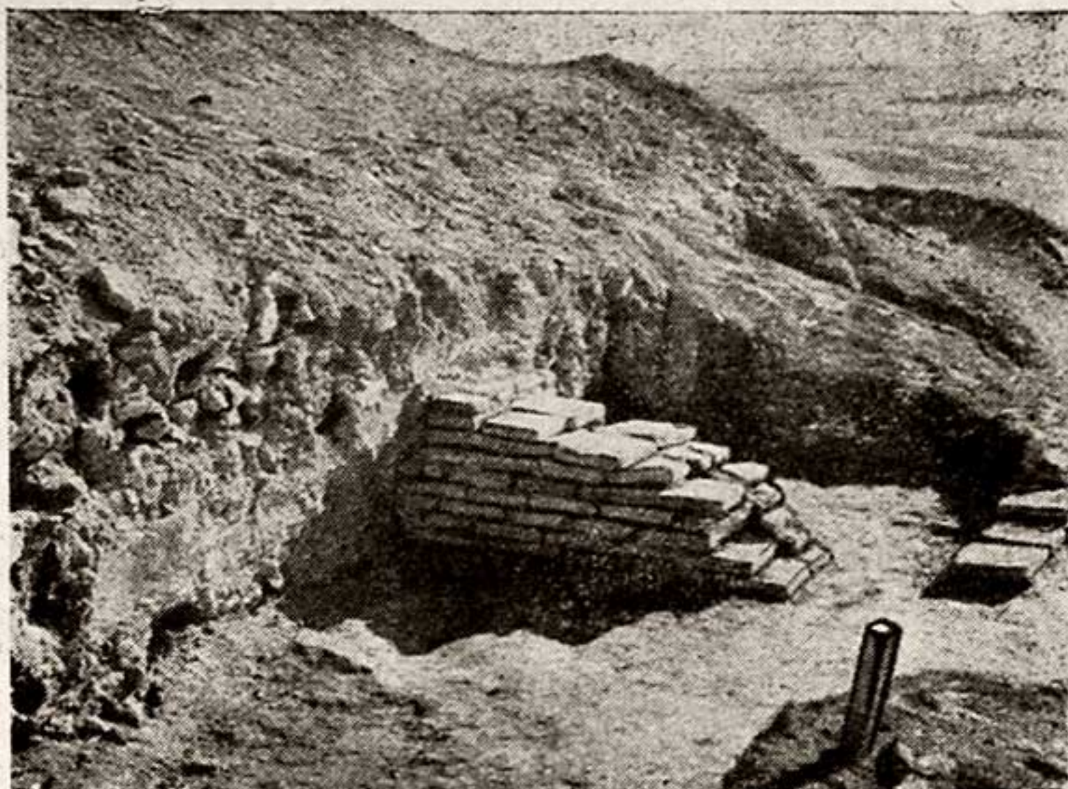
Рис. 22. Средневековая стена из жженого кирпича.
