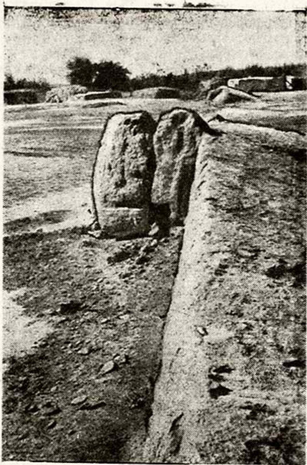
Рис. 3. Бурджа на южном фасае.
