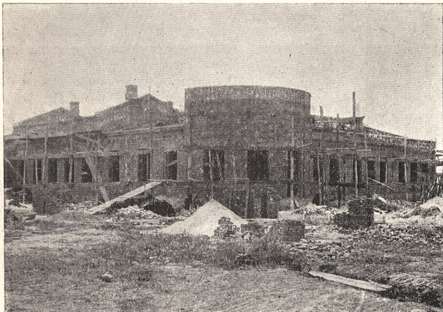
Строящаяся школа в Сталинабаде.
