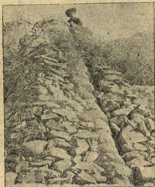
Водонапорная труба нохурской мельницы (составлена из ряда наложенных одно на другое больших каменных колес). (Фото Н. Фатгаха)
