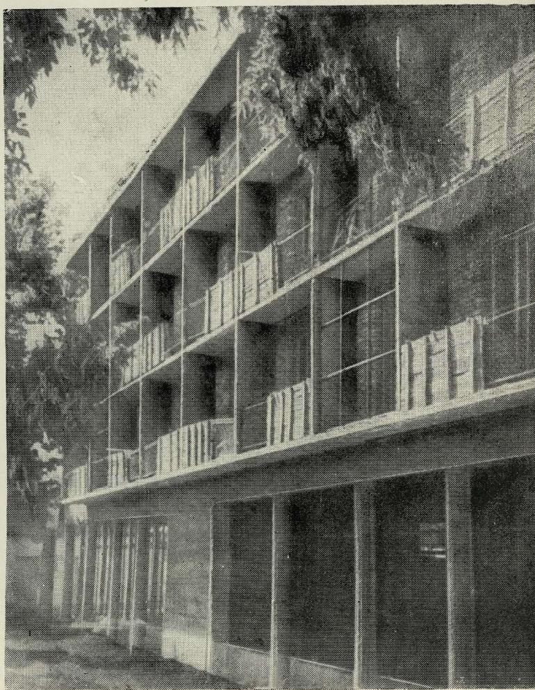
Жилой дом с жесткими диафрагмами. Архитекторы В. Афанасьев, В. Захаров, Г. Полторак, инженер-конструктор З. Ярмолинский. Вид строительства и фасады домов на улице Ленина в Сталинабаде
