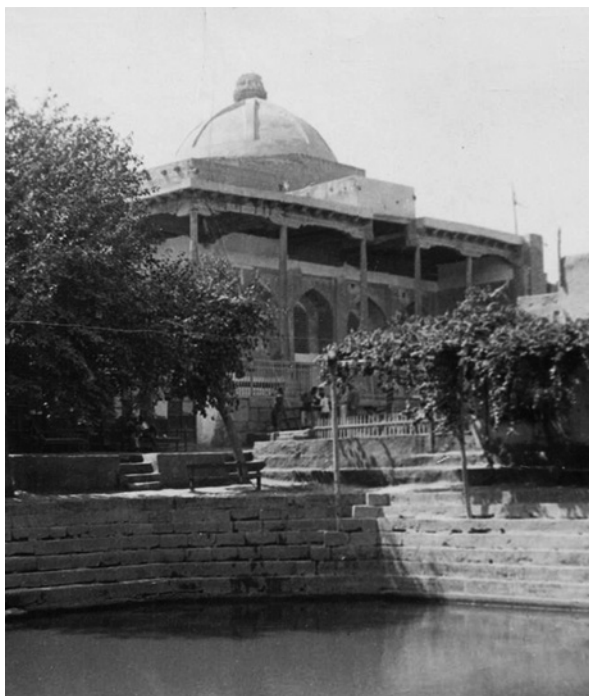
24. Хауз Ходжа-Зайнеддин в Бухаре. Общий вид
