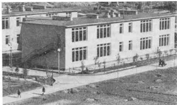
Здание школы в новом микрорайоне Душанбе.
