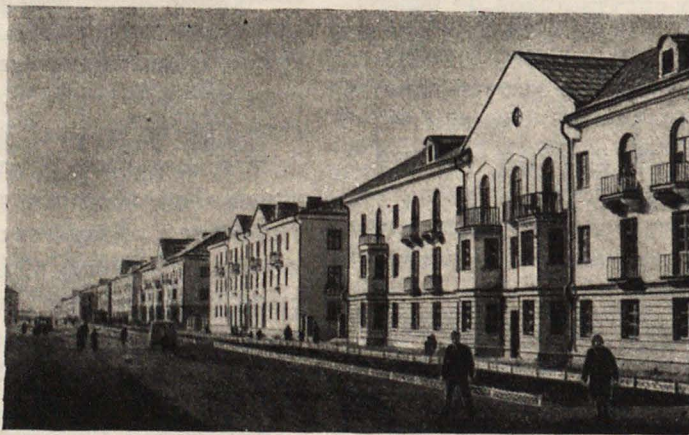
Жилые дома в Привокзальном районе
